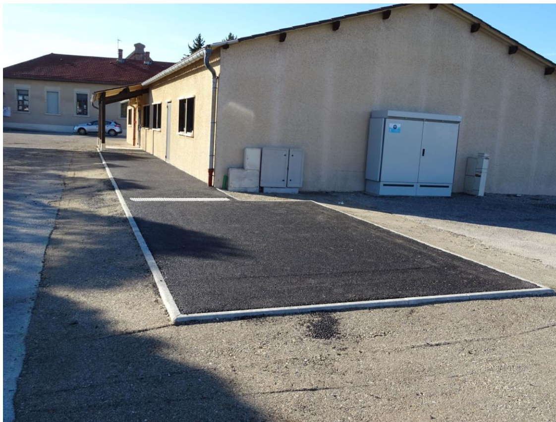
Emplacement PMR de la salle polyvalente en cours de réalisation (au 30 octobre 2020)
