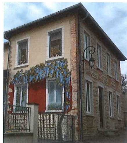
Les ouvertures en trompe l'oeil peuvent également animer une façade.
